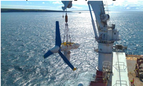
FOTO 2 | Installatie van getijdenenergie turbine
